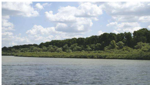
Figura nr. 12. Benzi împădurite pentru protecția malurilor - măsuri pentru consolidarea malurilor Dunării
